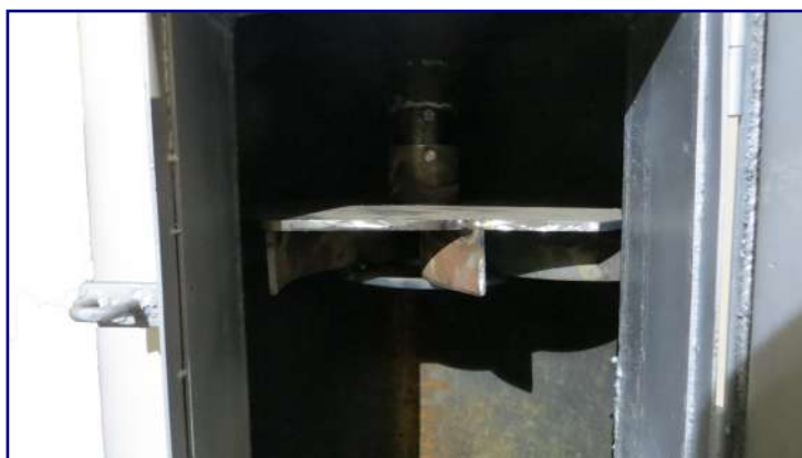
Рис. 7. Воздухораспределитель, установленный в шахте котла и поднятый в верхнее положение лебедкой ЛБ-540
