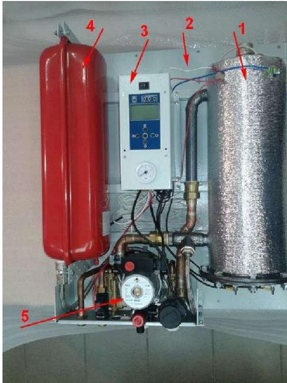
Рисунок 2. Общий вид водонагревателя «Star двухконтурный»
